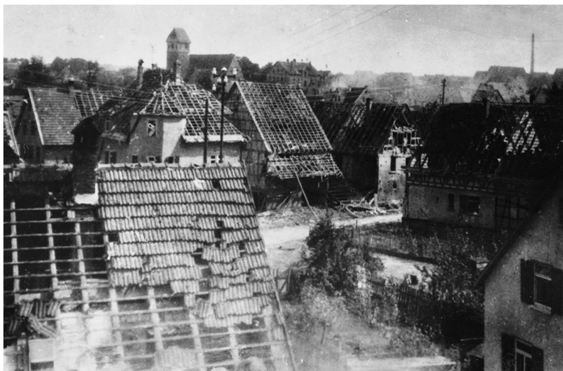
Abbildung 23: Schäden nach dem Bombenangriff auf Magstadt am 10.09.1944
