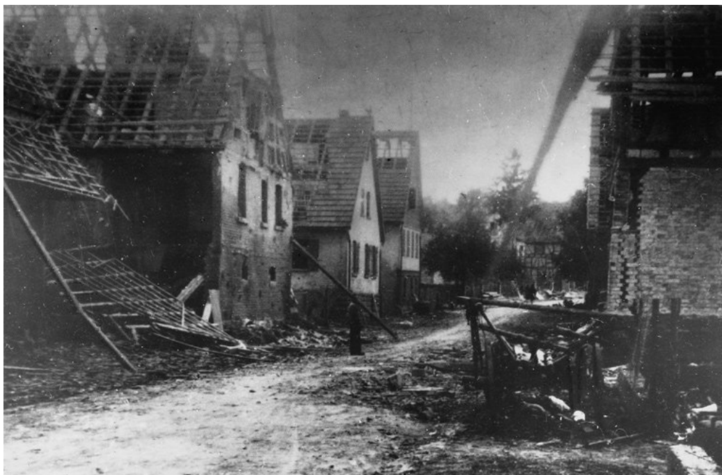
Abbildung 24: Schäden nach dem Bombenangriff auf Magstadt am 10.09.1944
