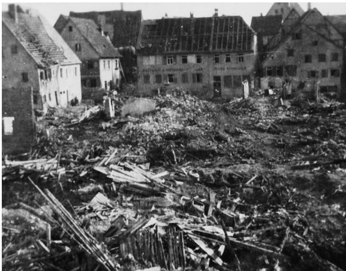
Abbildung 25: Schäden nach dem Bombenangriff auf Magstadt am 10.09.1944
