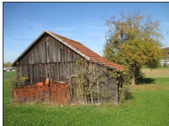
Blick auf zentralen Schuppen Richtung Nordwesten
